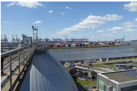
Blick von den Faultürmen auf den Köhlbrand u. Elbe
